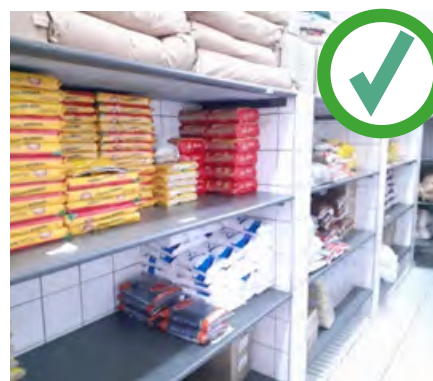
Prateleiras de ardósia e alvenaria revestidas com azulejo
