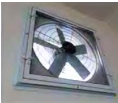
Exaustores de parede com tela milimétrica removível
